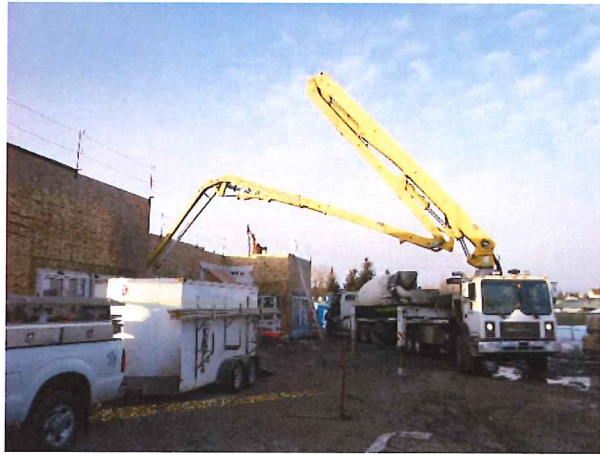
Pump Truck for Slab Pour
